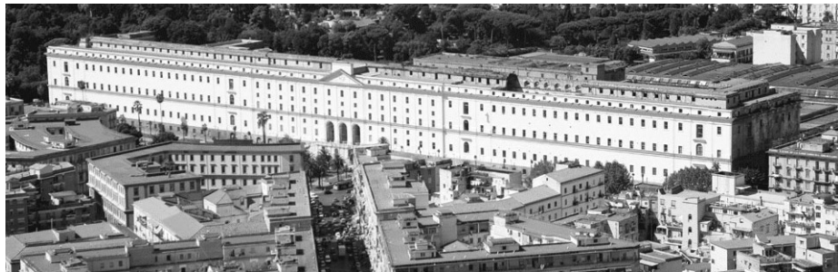
Palazzo Fuga, Real Albergo dei Poveri, Napoli (1746-1772)
